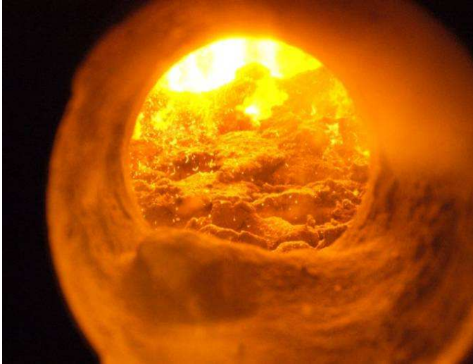
Figura 13. Central de biomasa de Sant Pere de Torelló. Almacén de combustible y quemador de la caldera
