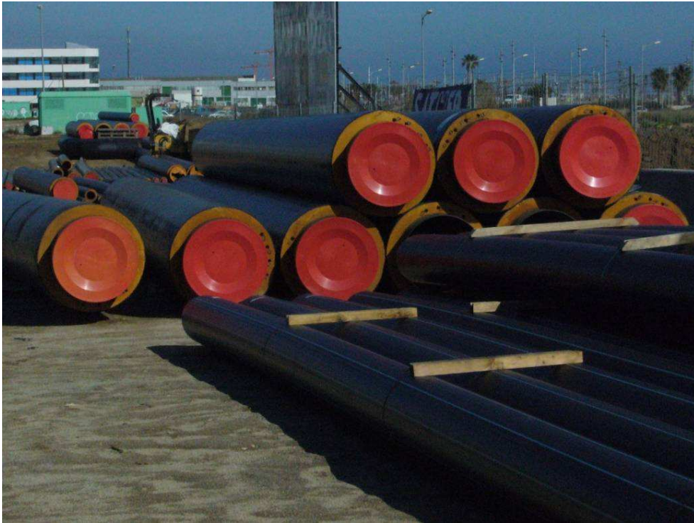
Figura 2. Tuberías pre-aisladas para una red de distrito
